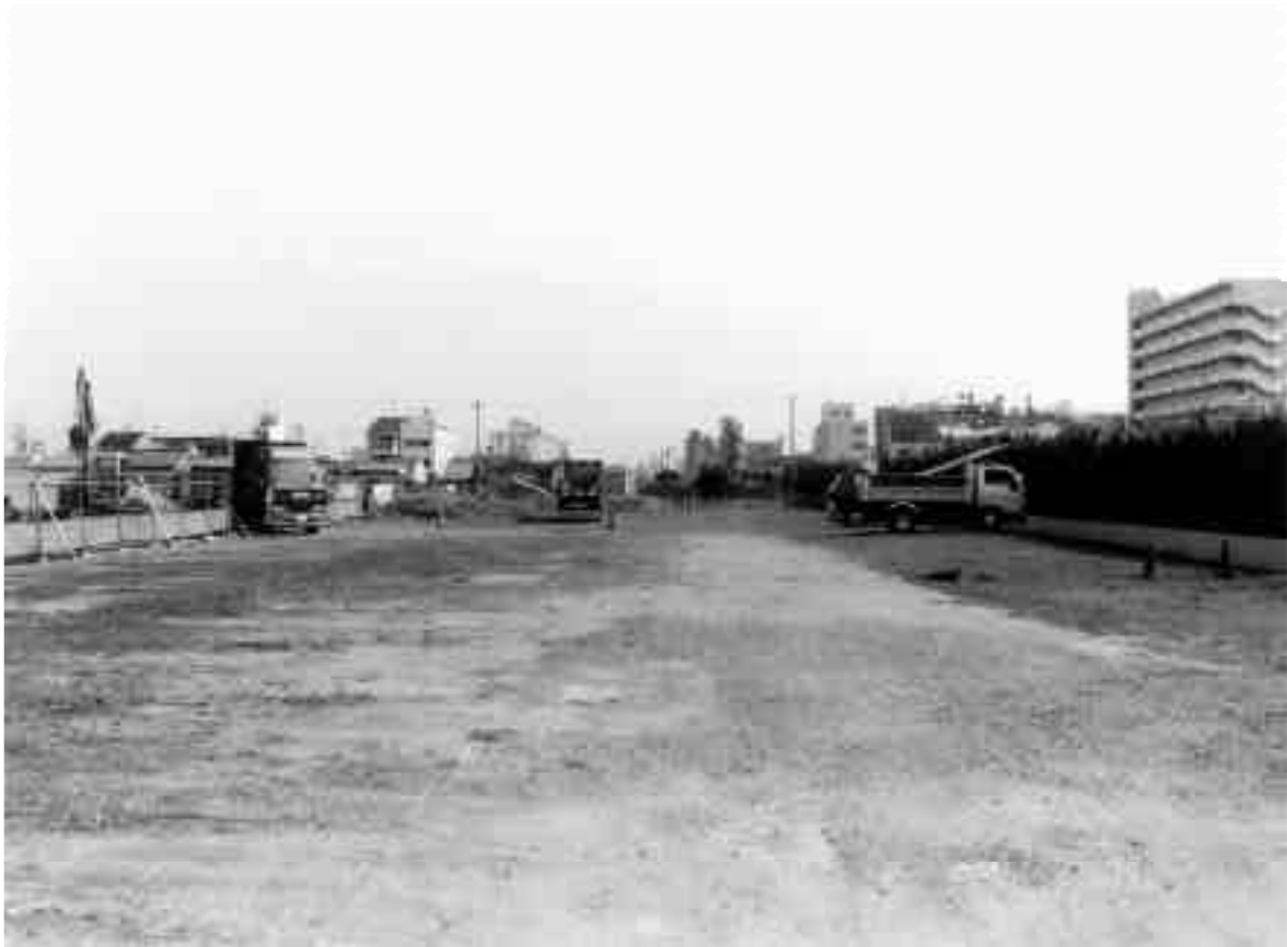
2 2・3区調査前全景
