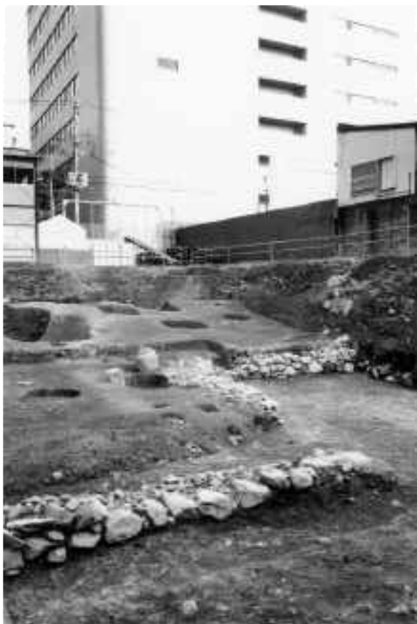
1 第2面石垣149・石垣151・石垣150(北西から)
