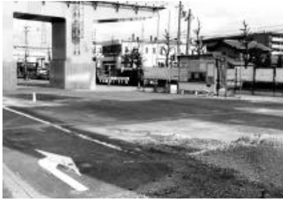
図2 調査前全景（南から）
