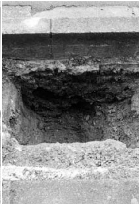
4 B 1区全景（南から）
