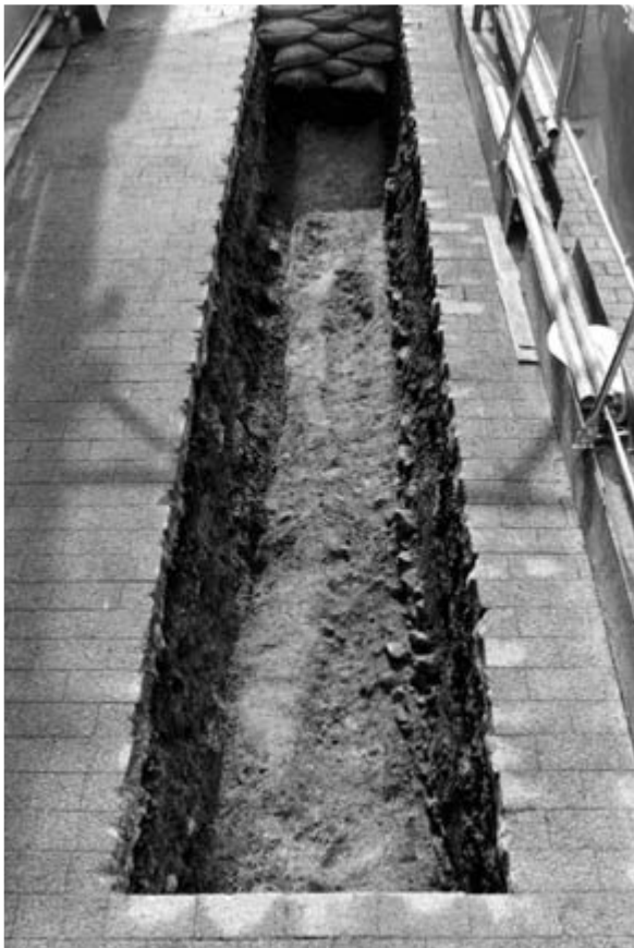
3 A 7区T 2全景（北から）
