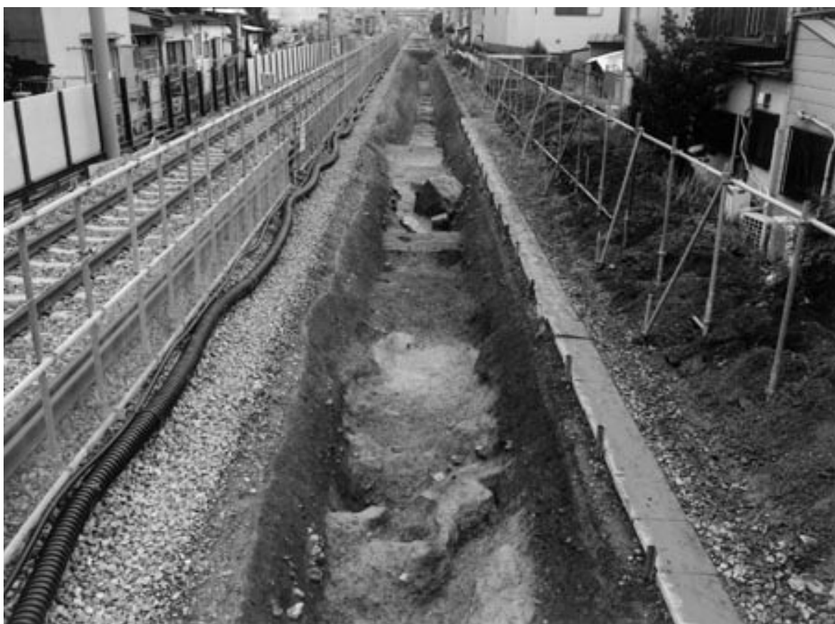
2 2B区西半（西から）
