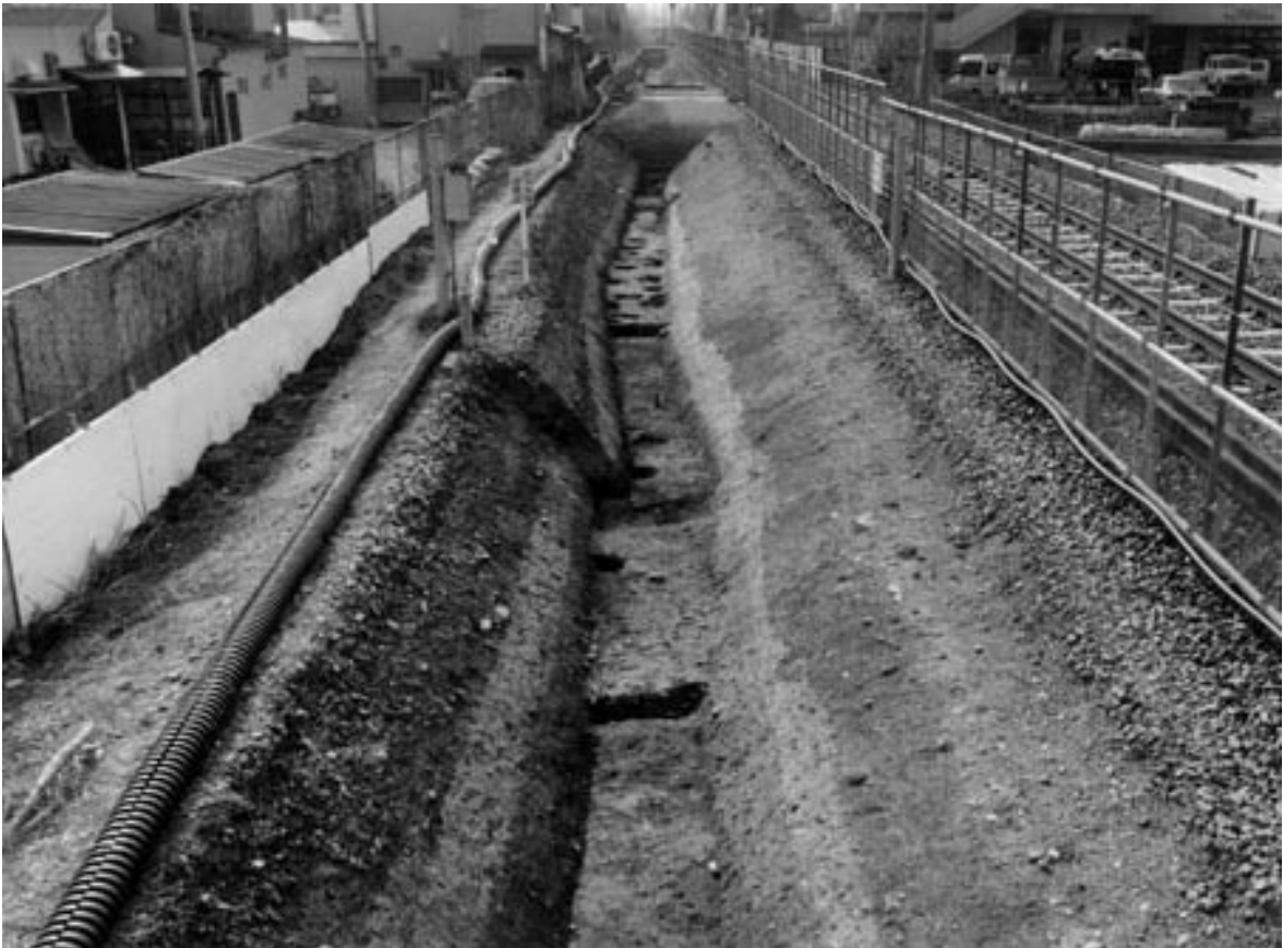
2 2C区全景（東から）
