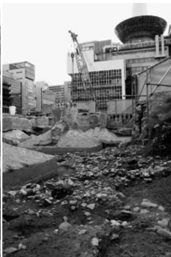
3 池 550 洲浜西部 (北から)
