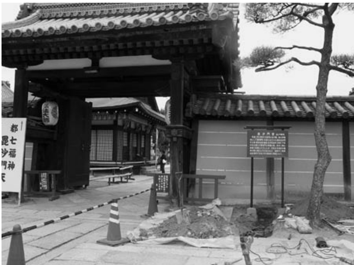
1 立会No.4 (東から)
