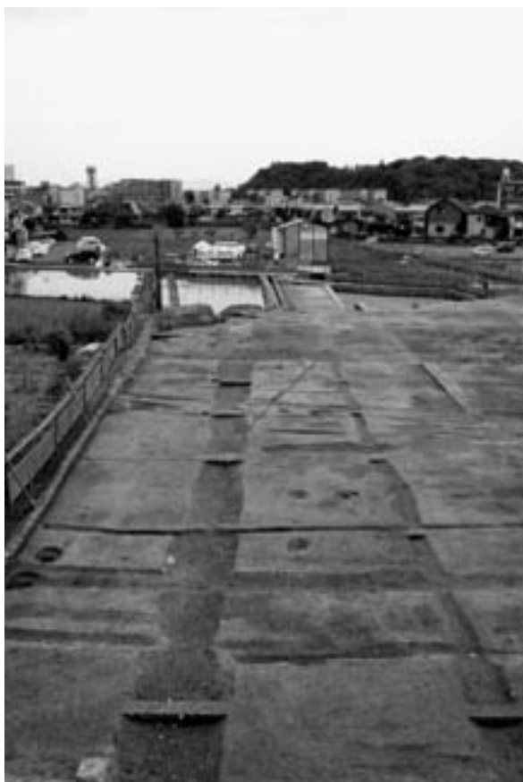
2 I区 長岡京期 一条大路南側溝上層掘削状況（西から）
