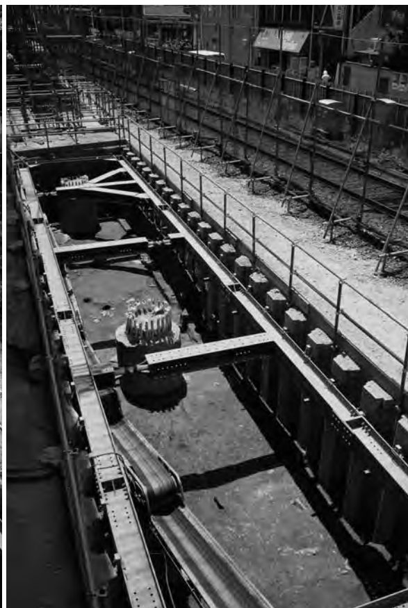
2 C2区第6面全景(北東から)
