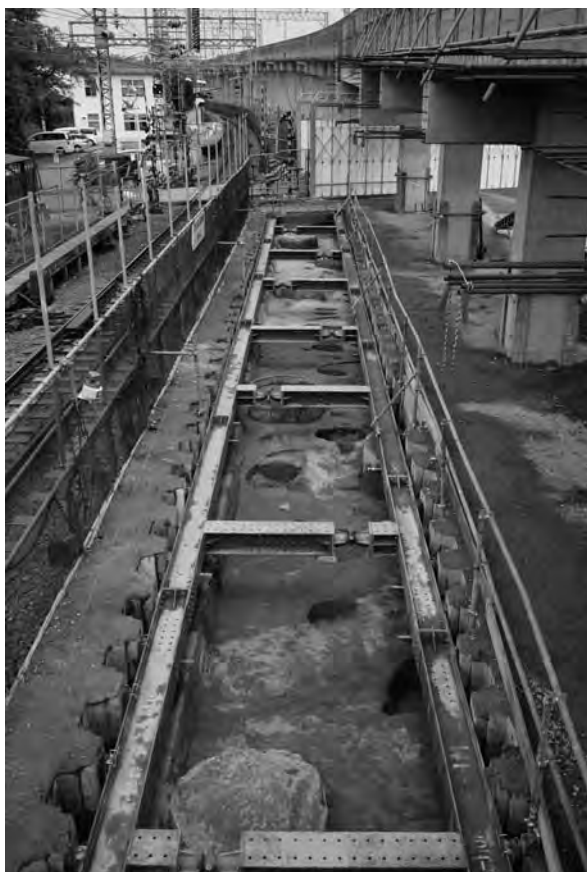
3 A2区第2面全景（南西から）
