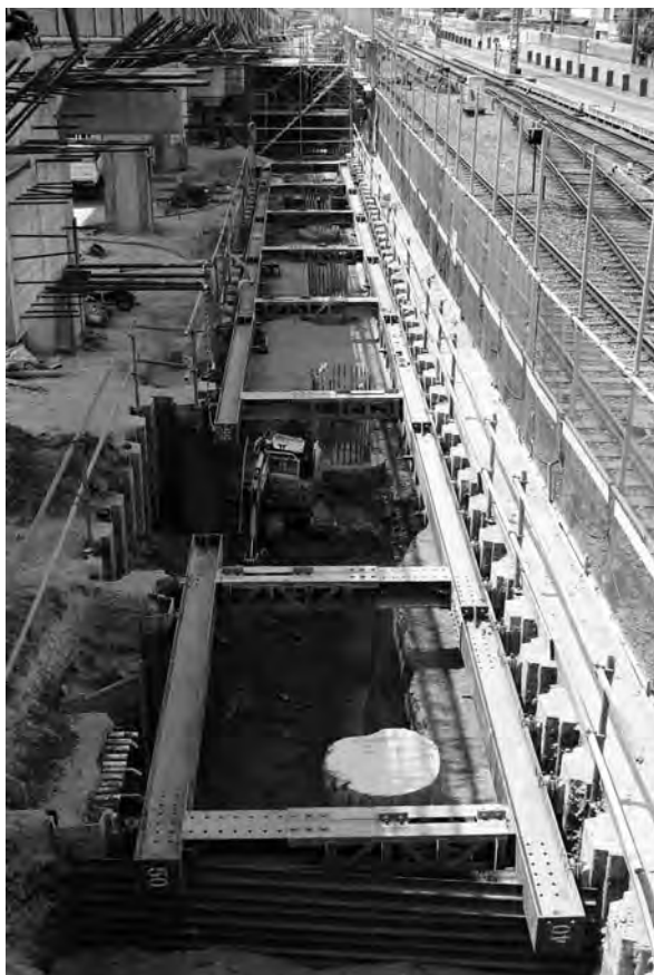
1 A1区全景（北東から）
