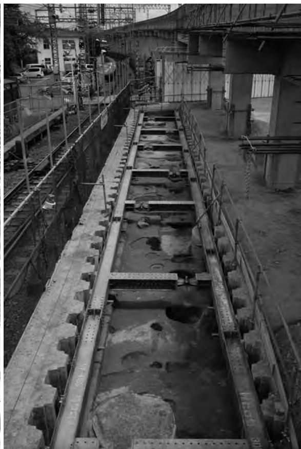
2 A2区第1面全景（南西から）
