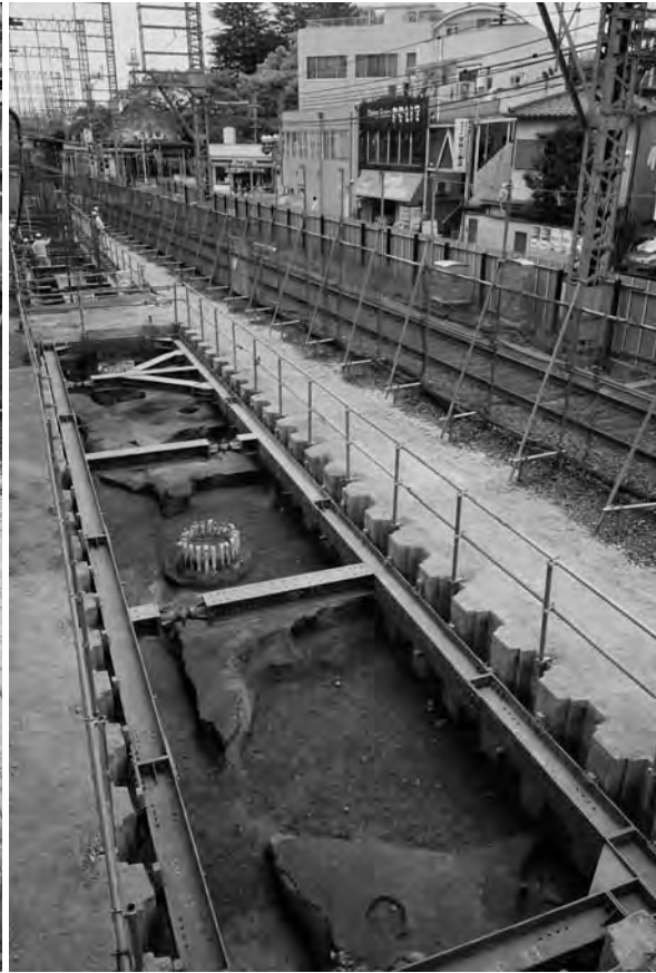
2 C2区第1面全景(北東から)
