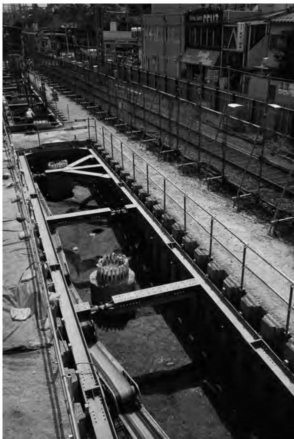
1 C2区第4面全景(北東から)
