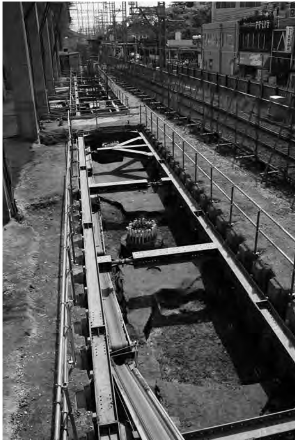
3 C2区第2面全景(北東から)
