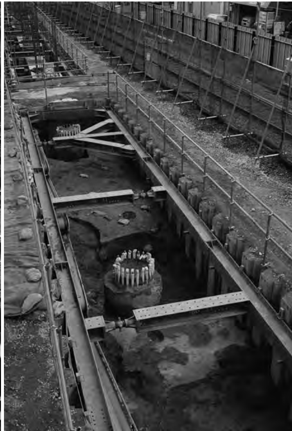
4 C2区第3面全景(北東から)
