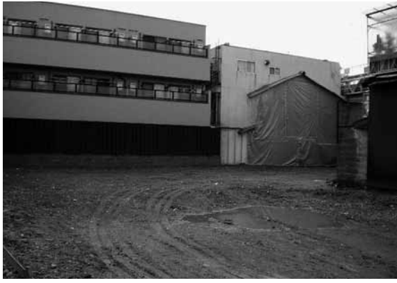
図2 調査前全景（北西から）
