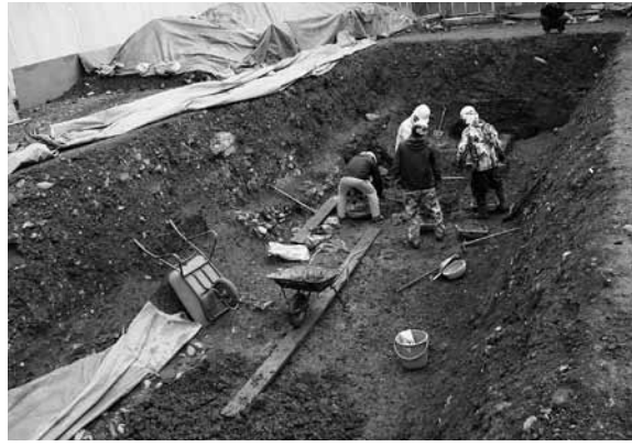
図3 作業風景（北から）
