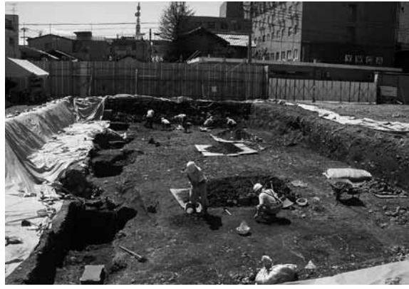
図3 作業風景（東から）
