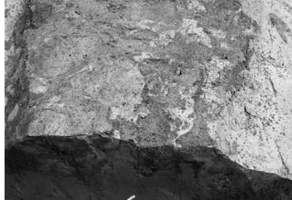
図5 1区噴砂状砂部断割り状況
