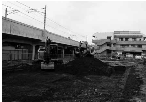
図4 2区重機掘削状況 (北東から)
