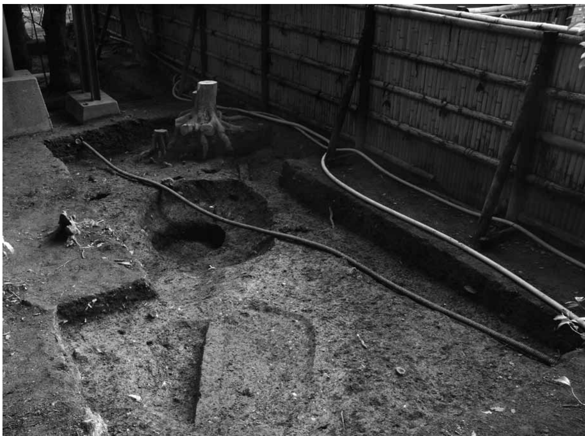
2 3区全景（拡張後、北から）
