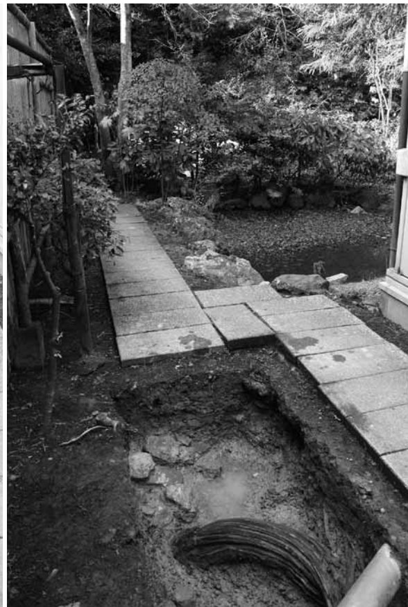
2 8区石組検出状況（南東から）
