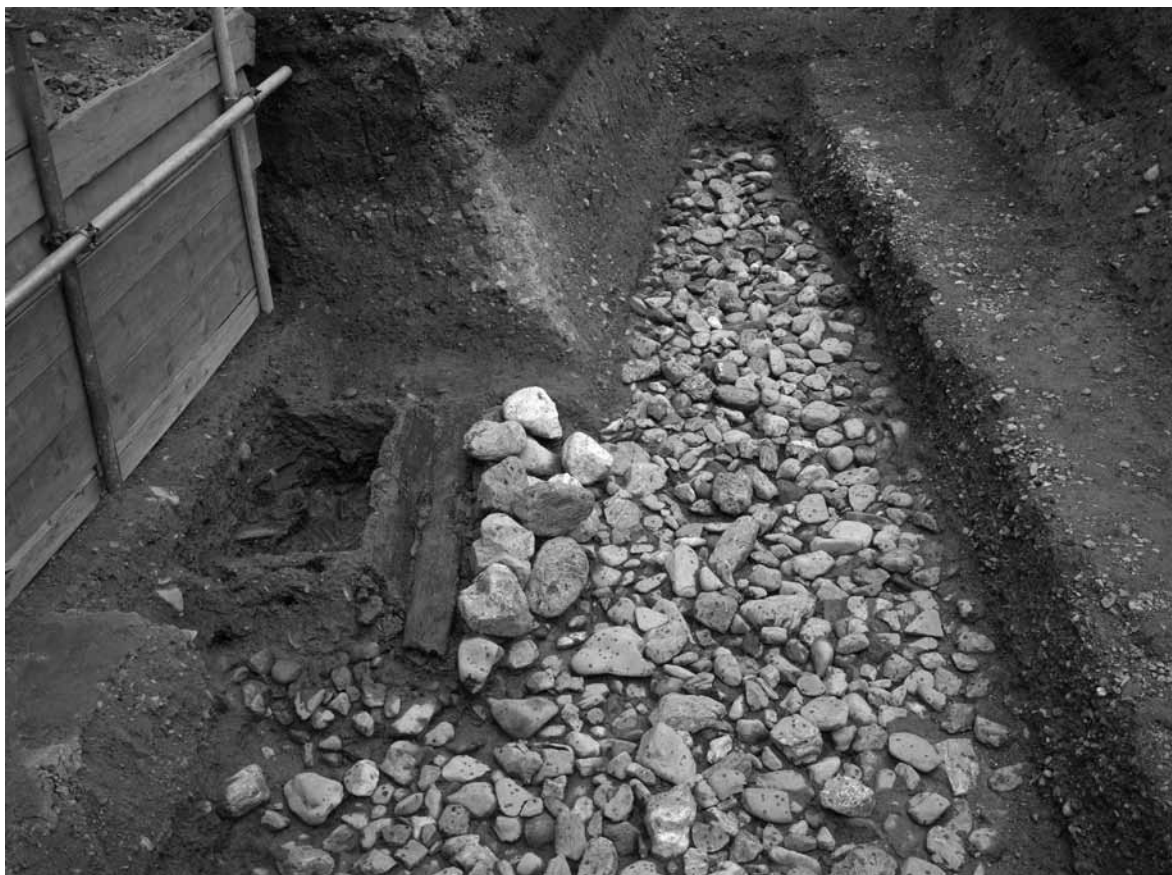
1 馬代小路東側溝内石敷SD29と木枠組施設（北から）
