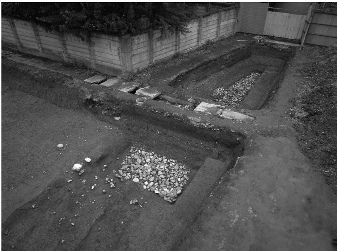
2 西半全景（北西から）
