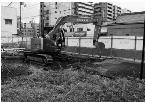
図9 3区重機掘削状況（南西から）
