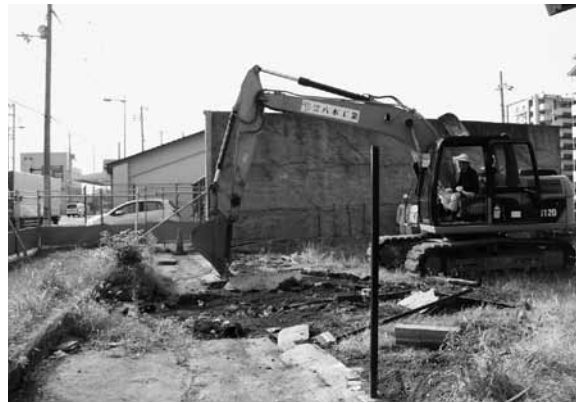
図6 2区重機掘削状況（北から）
