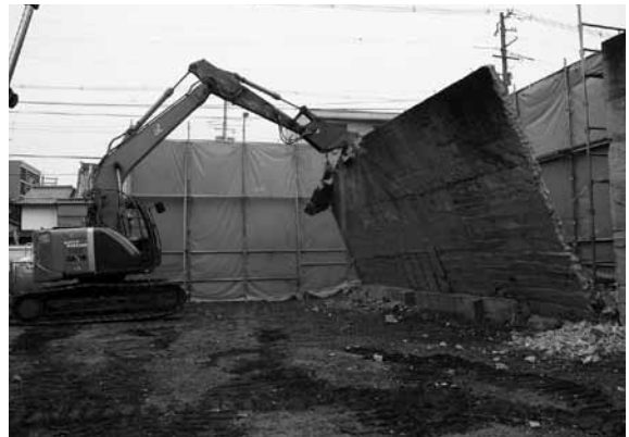
図8 コンクリート擁壁の切削解体状況（西から）
