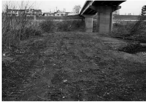
図3 埋め戻し状況（北西から）
