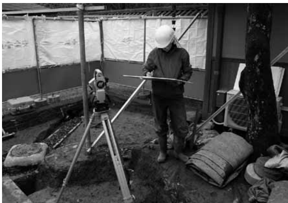
図4 1区作業風景（北西から）
