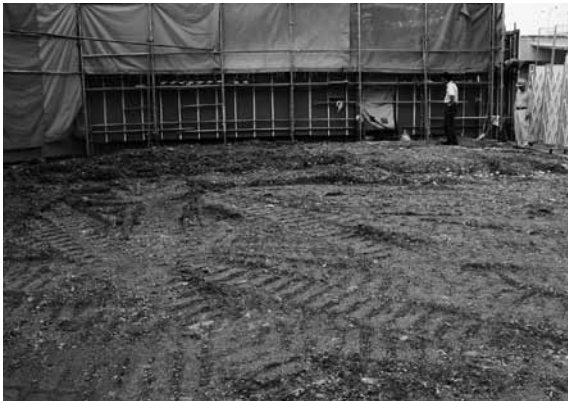
図7 E区調査前全景（南から）
