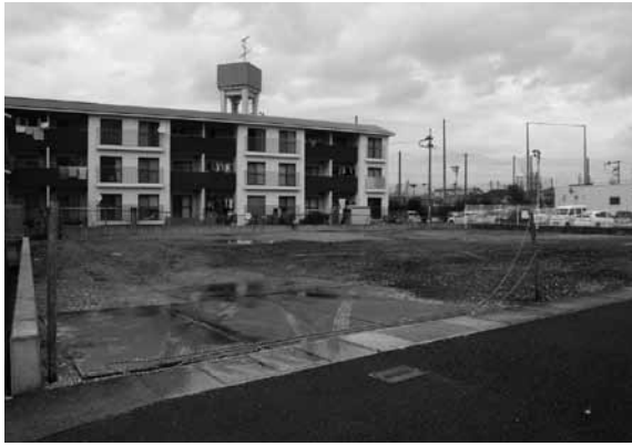
図2 調査前全景（南西から）
