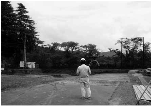
図8 1区ドローン撮影作業風景（北西から）
