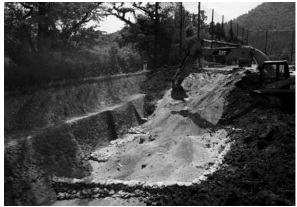
図9 1区礎石建物保護状況（北東から）
