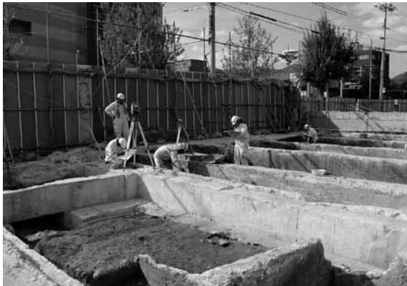
図4 作業風景2（南東から）
