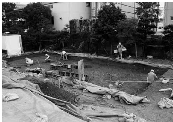
図4 作業風景 (北西から)
