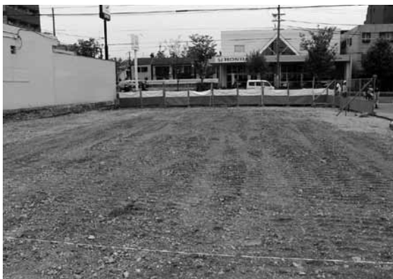
図3 調査前全景（西から）
