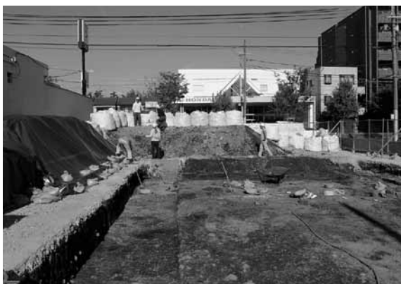
図5 作業状況（西から）
