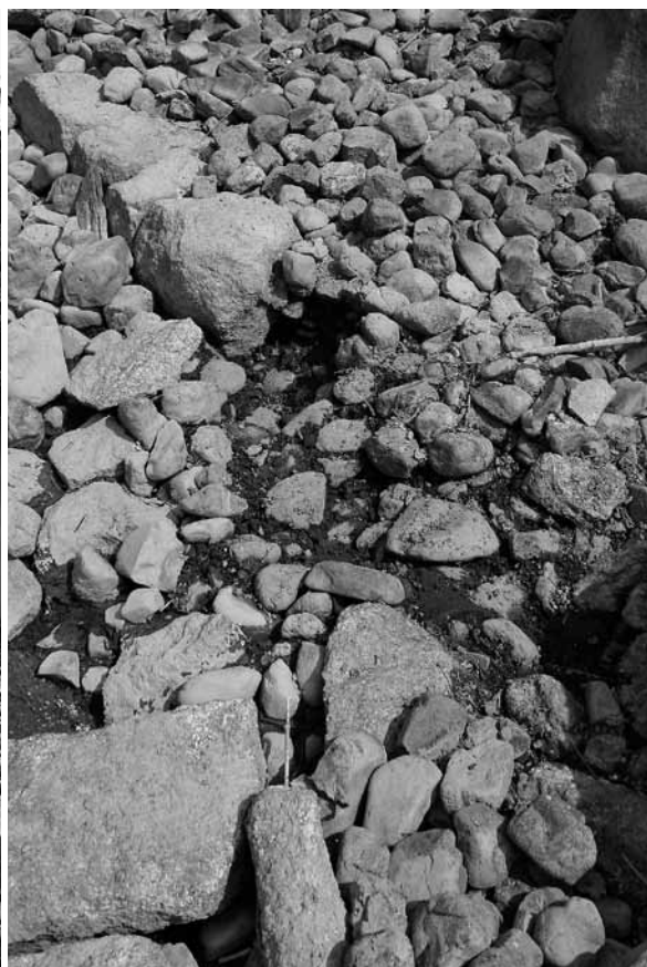
3 追加調査（南東から）
