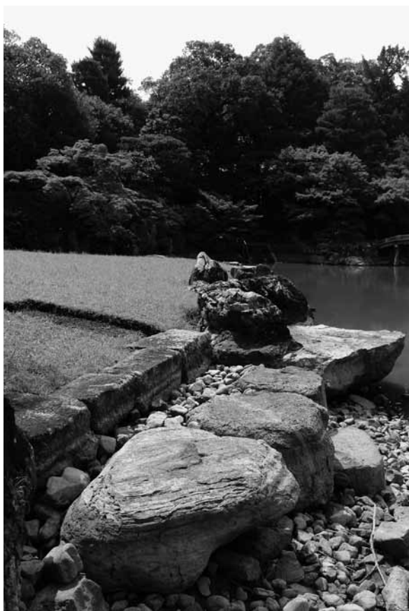
2 2区護岸全景（北西から）
