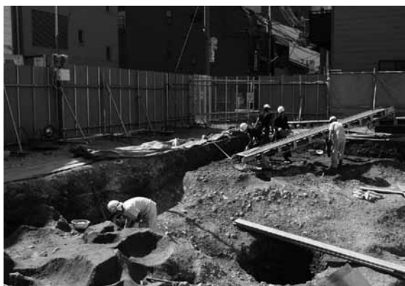
図5 1区調査状況 (北から)
