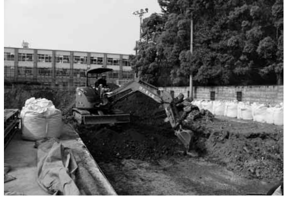
図4 重機掘削状況（南西から）
