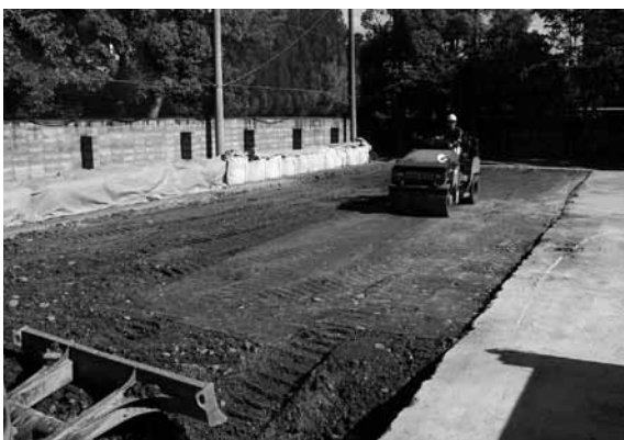
図9 ローラーによる埋め戻し状況（北西から）
