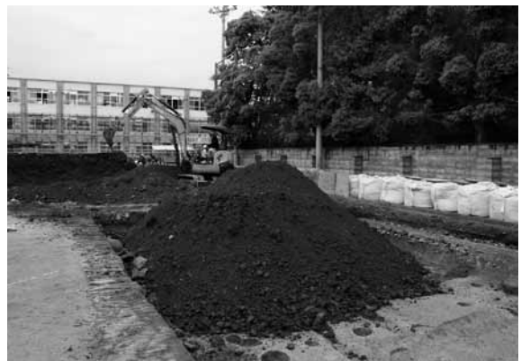
図8 重機による埋め戻し状況（南西から）
