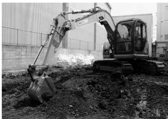
図4 重機掘削 (北西から)
