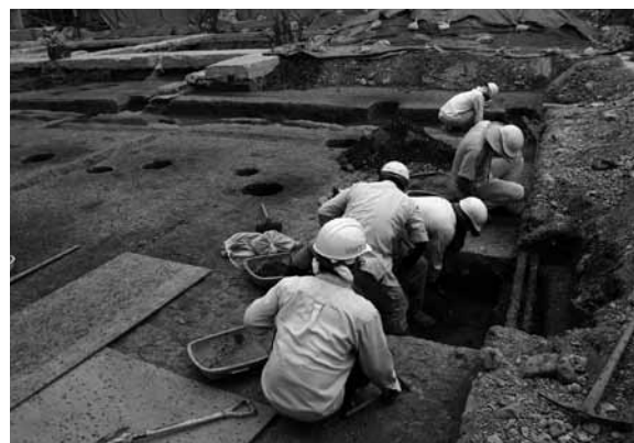
図4 作業状況（北西から）
