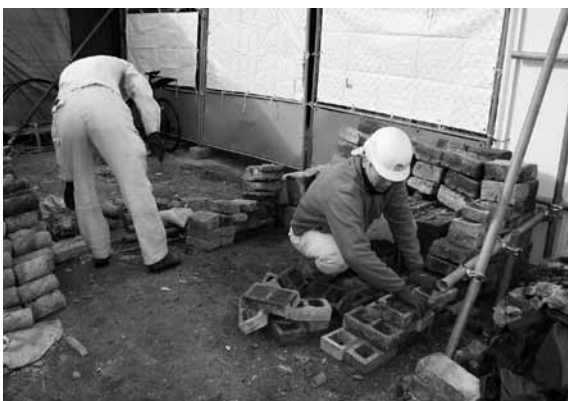
図7 煉瓦ナンバリング作業状況（北東から）
