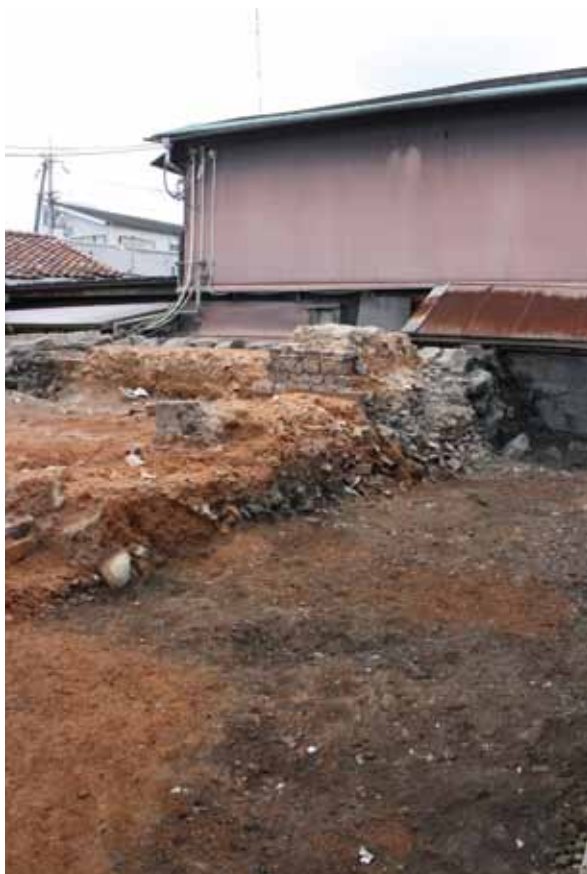
3 古段階：土台（南東から）
