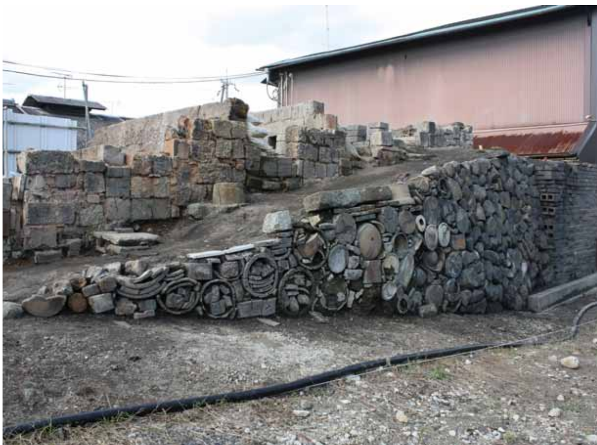
2 土台（石垣）（南東から）
