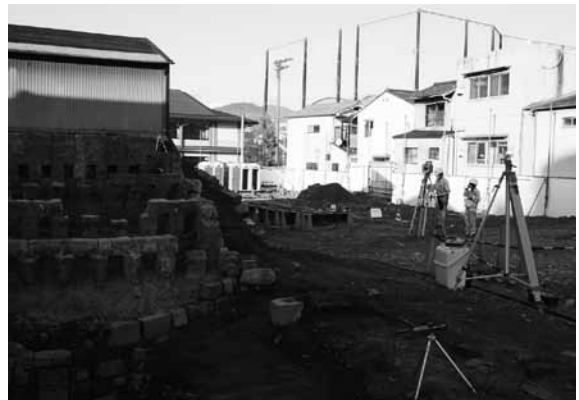
図4 レーザー測量作業状況（北西から）
