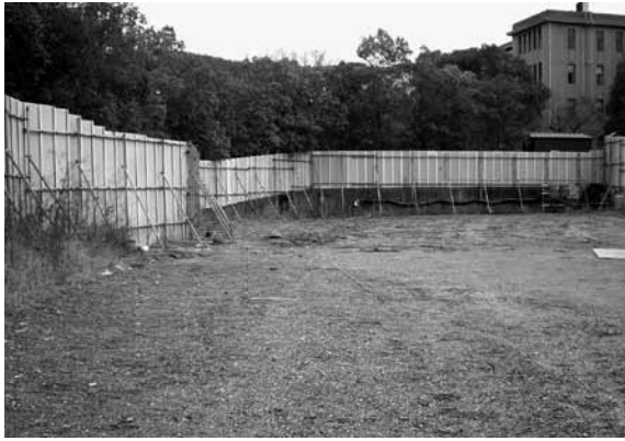
図2 調査前全景（西から）
