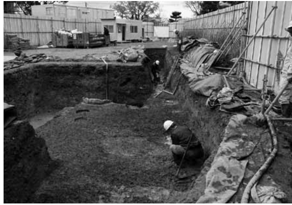
図3 作業風景（東から）
