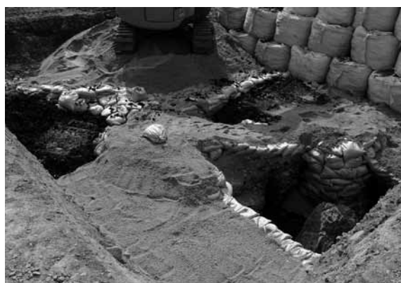
図6 砂養生による埋め戻し状況 (北西から)
