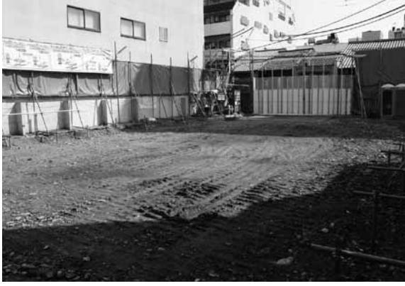
図3 調査前全景（南西から）
