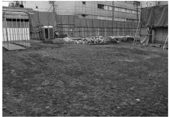
図6 埋め戻し後全景（北西から）
