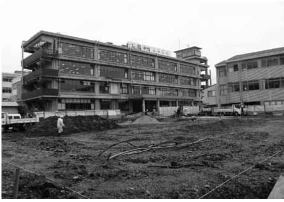
図3 調査前全景（南西から）
