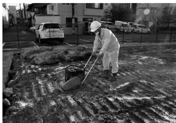
図6 転圧作業 (北東から)
