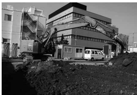
図5 重機掘削 (南東から)
