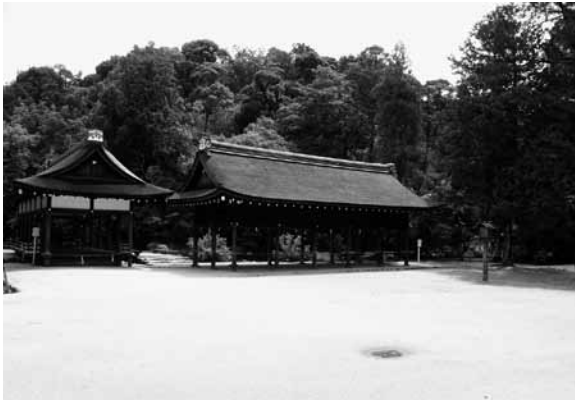
図3 調査前全景（西から）
