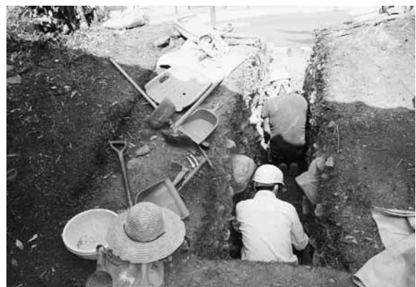
図6 2区作業状況（西から）
