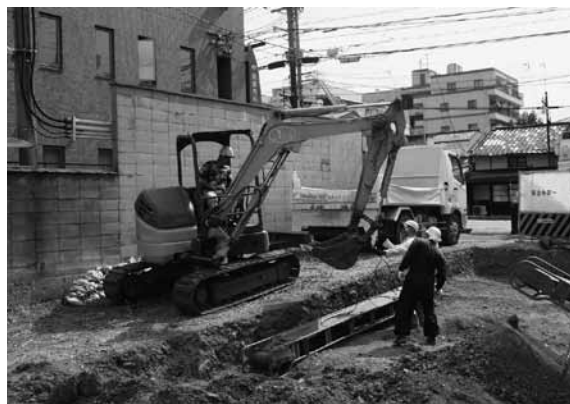
図4 作業状況 (南西から)
