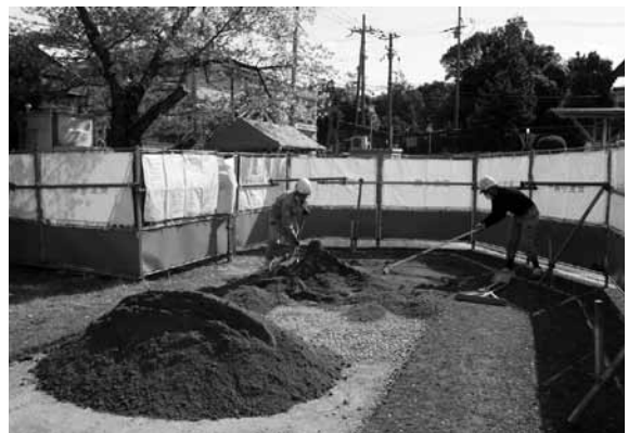
図8 6区埋め戻し状況（北西から）
