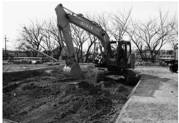
図6 5区重機掘削状況（北東から）
