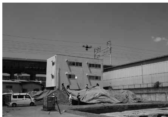
図4 作業状況 (南西から)
