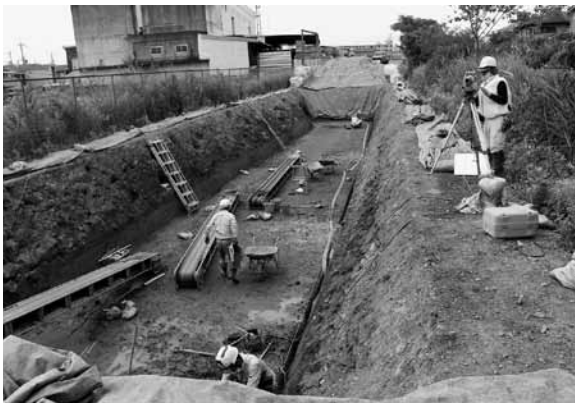
図9 3区作業状況（北西から）
