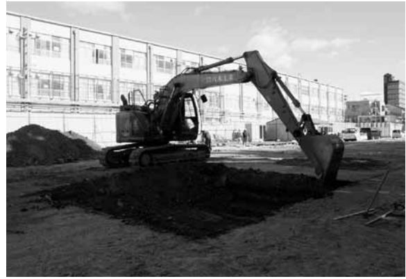
図4 1区重機掘削状況（南西から）
