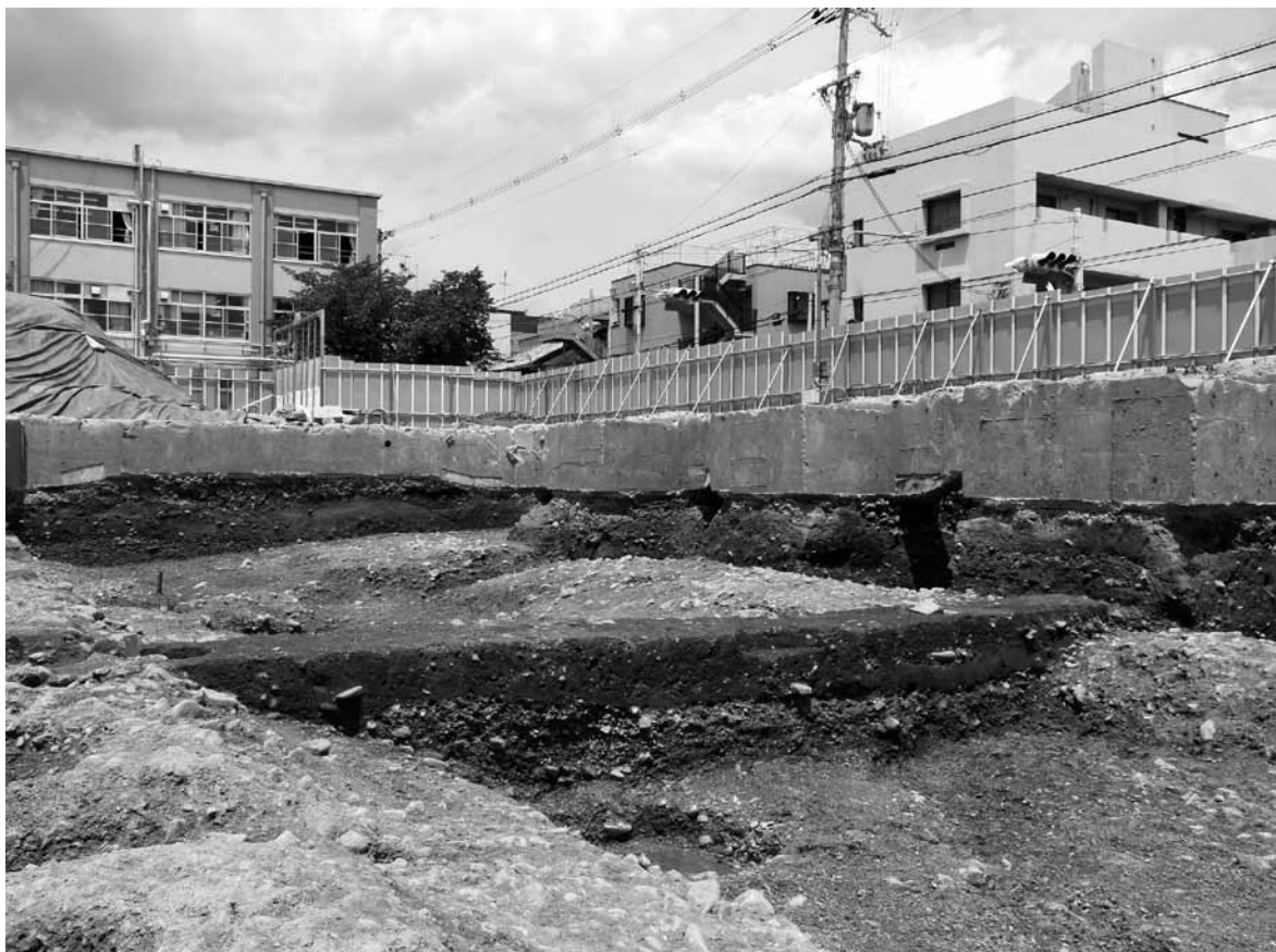
1 2区溝900（道祖大路西側溝）東西セクション断面（南西から）
