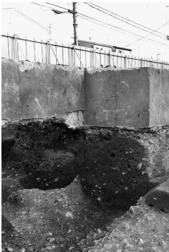
2 2区溝351・150・945合流点 (北西から)
