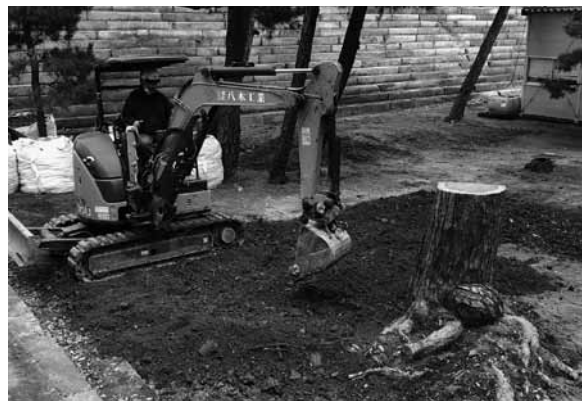
図6 埋戻し状況 (北西から)
