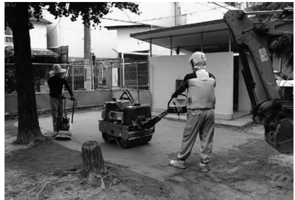
図8 3区転圧埋戻し状況（北西から）
