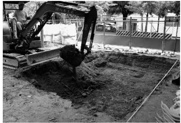
図6 2区重機掘削状況（北西から）
