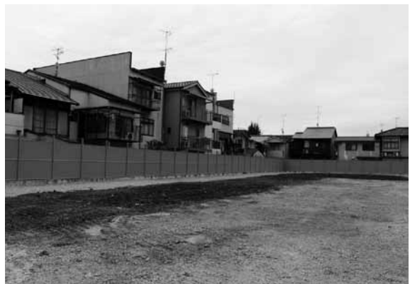
図6 埋め戻し後状況 (北東から)
