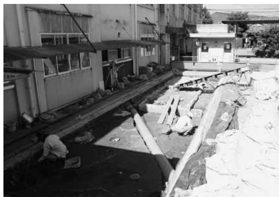
図4 作業状況 (北東から)
