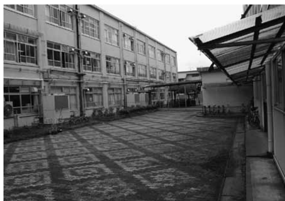
図3 調査前全景 (南西から)
