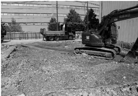
図3 調査前全景 (南東から)
