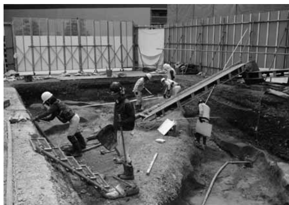
図4 作業状況 (北から)
