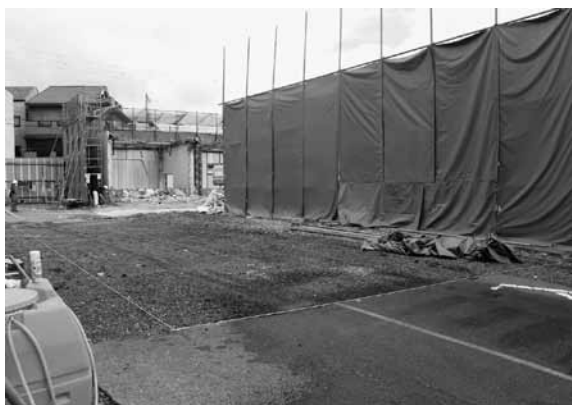
図3 調査前全景 (南から)
