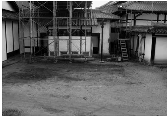
図15 15区調査前全景（北から）
