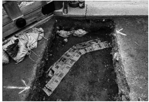
図21 8区埋戻し状況（東から）
