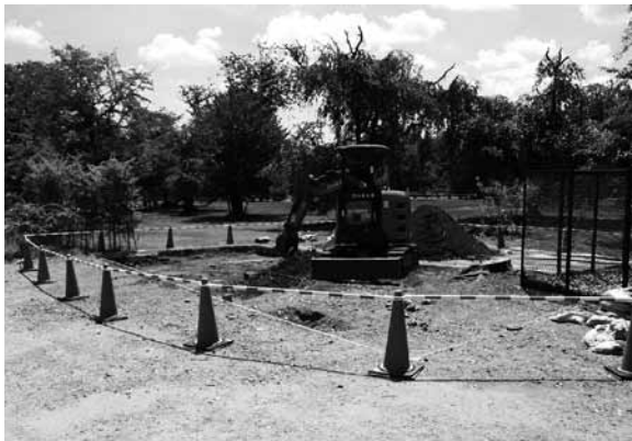
図16 3区重機掘削状況（北東から）
