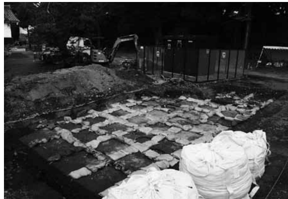
図17 3区保存埋戻し状況（南東から）
