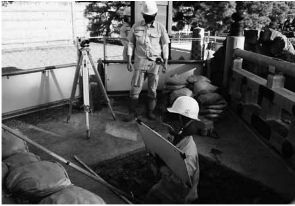
図20 8区作業状況（北西から）
