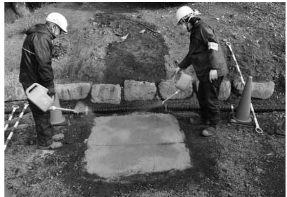
図25 12区マサファルト仕上げ状況（西から）
