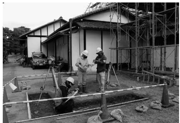
図27 15区作業状況（西から）
