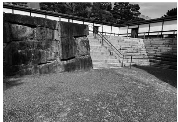
図11 10区調査前全景（南東から）
