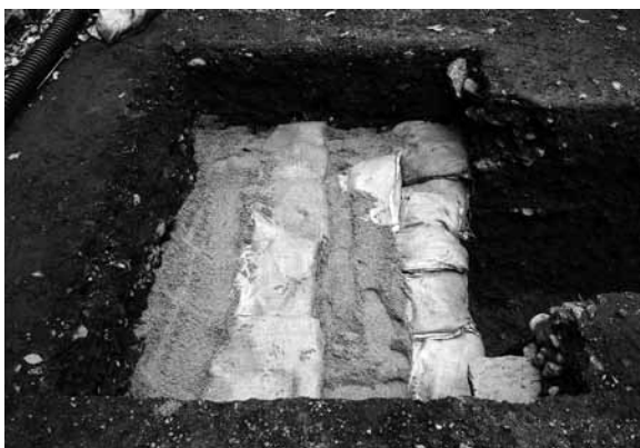
図18 4区保存埋戻し状況（北から）
