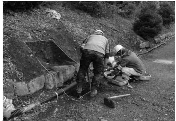
図23 12区作業状況（北西から）
