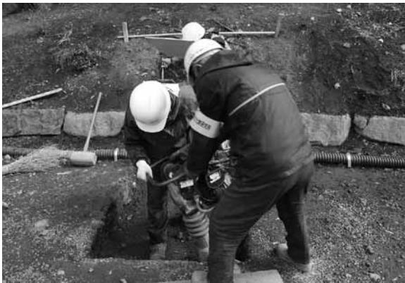
図24 12区転圧埋戻し状況（西から）
