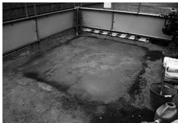
図19 7区マサファルト埋戻し状況（北西から）
