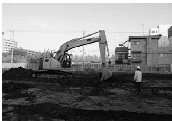
図3 1区重機掘削状況（西から）
