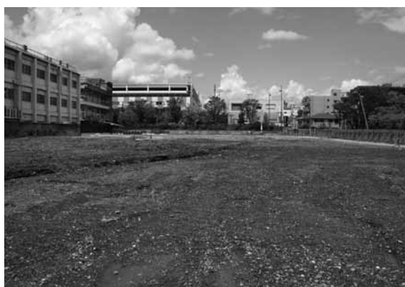
図7 埋め戻し状況（南から）
