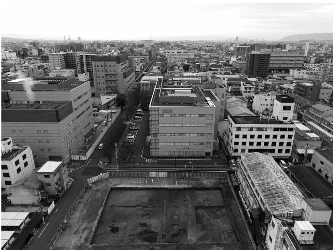
1 調査地遠景〔1区〕(北から)
